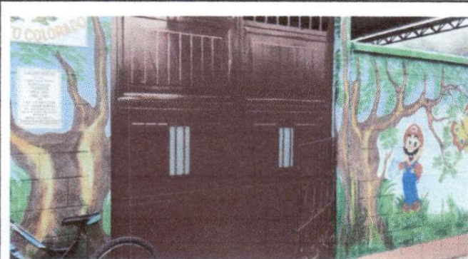
Foto 3. Sustitución de Porton Principal
