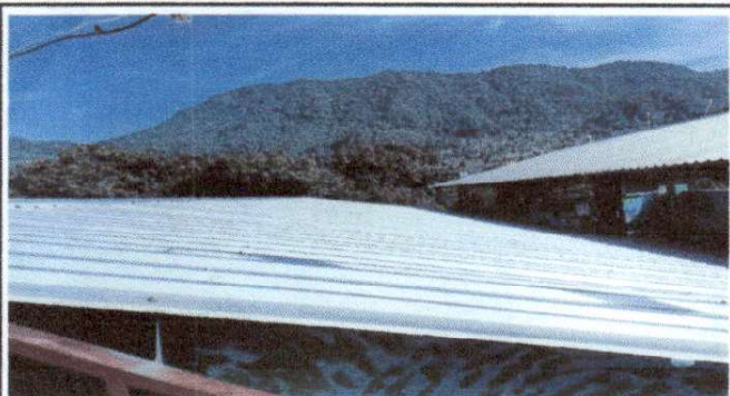
Foto 1. Cubierta de lamina
