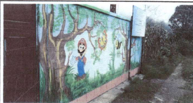
Foto 4. Pintura en muro exterior e interior.
